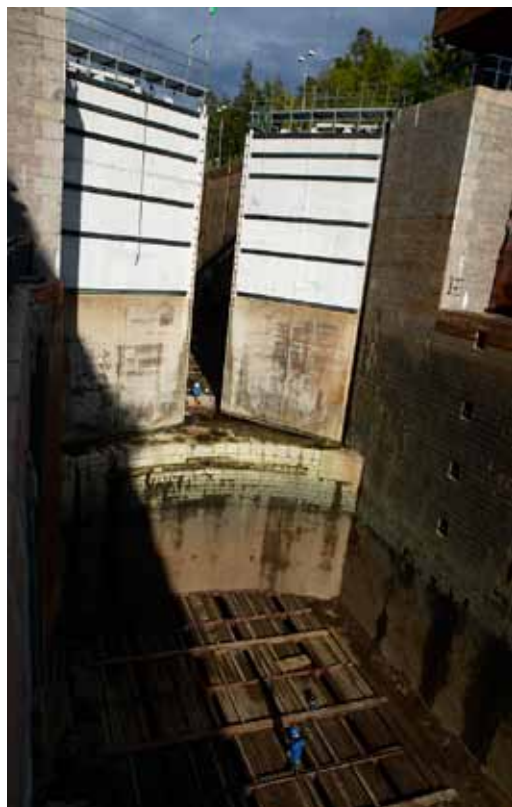
1916-års slussled, tömd på vatten för ett kortare reparationsarbete i maj 2004.
