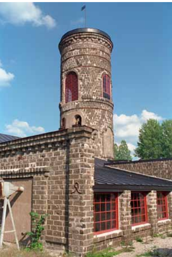
Under Gröndalslaven i Klackberg finns ett nära 350 meter djupt schakt.
